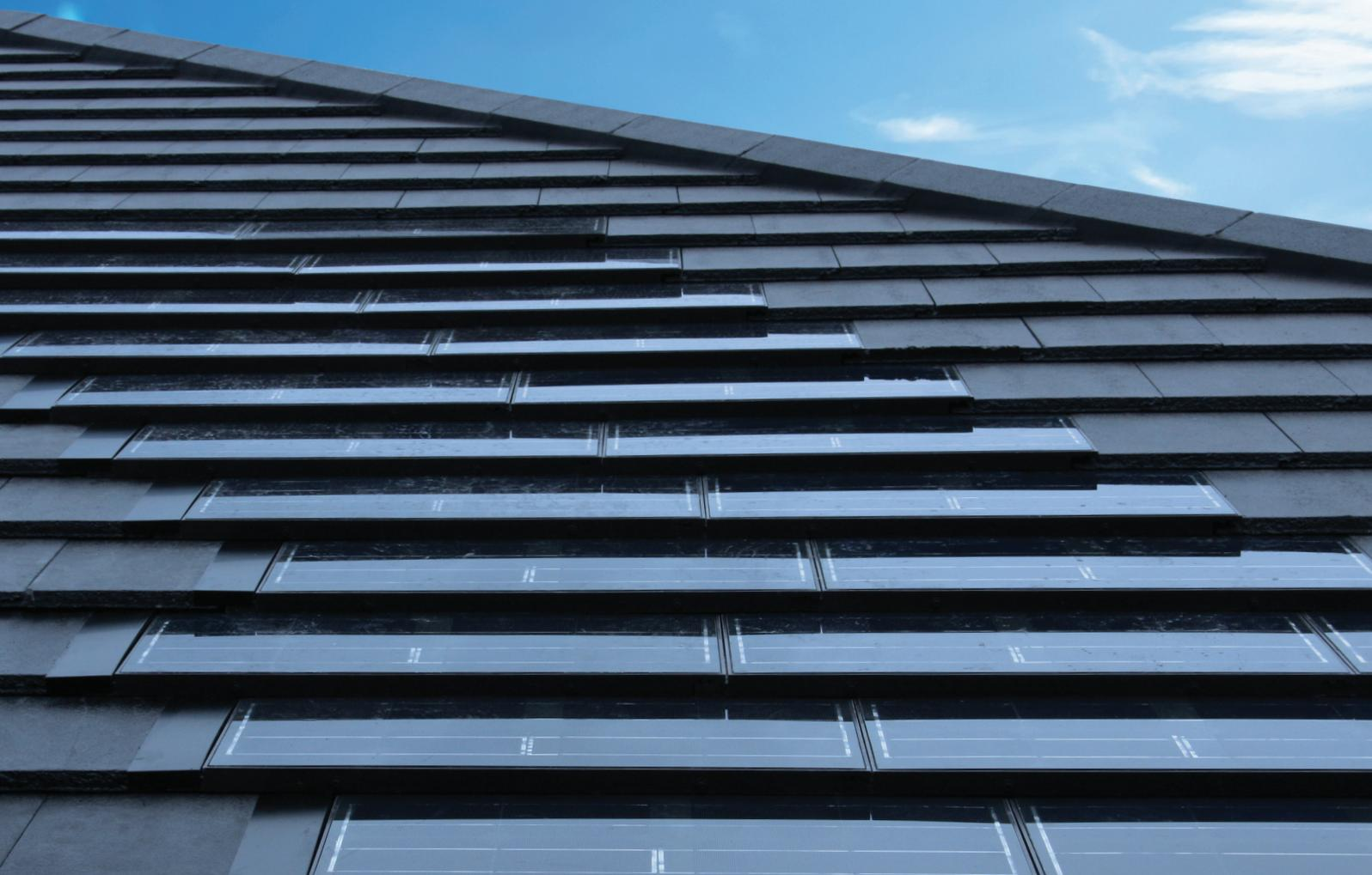
**INTEGRATED MODULAR PHOTOVOLTAIC FLAT TILE SYSTEM**
